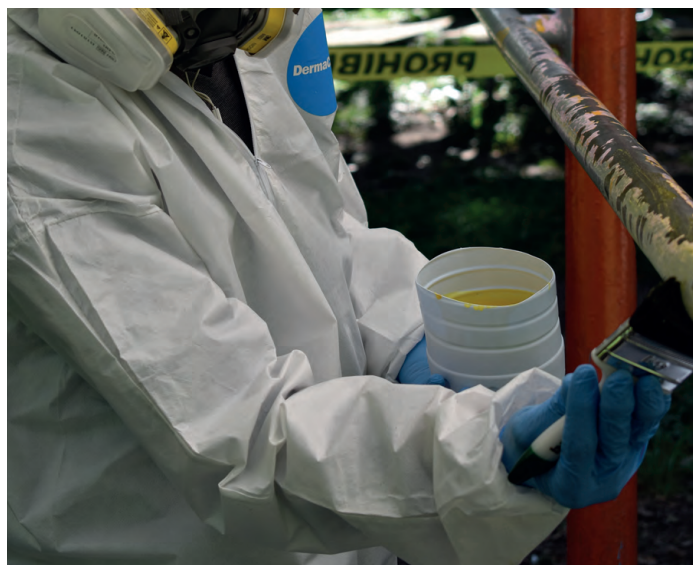
Figura 11. Aplicación del removedor.
