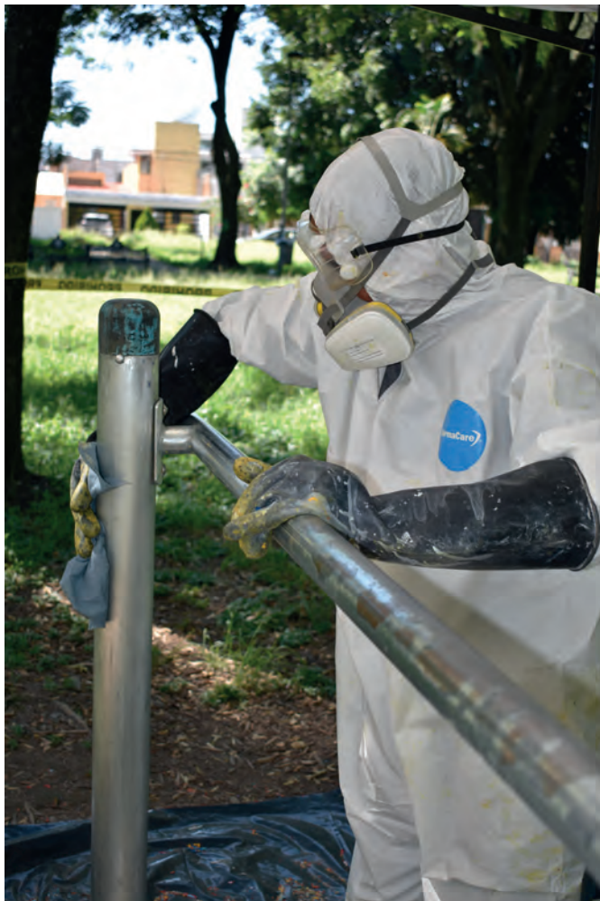
Figura 14. Secado en húmedo para la eliminación de impurezas.
