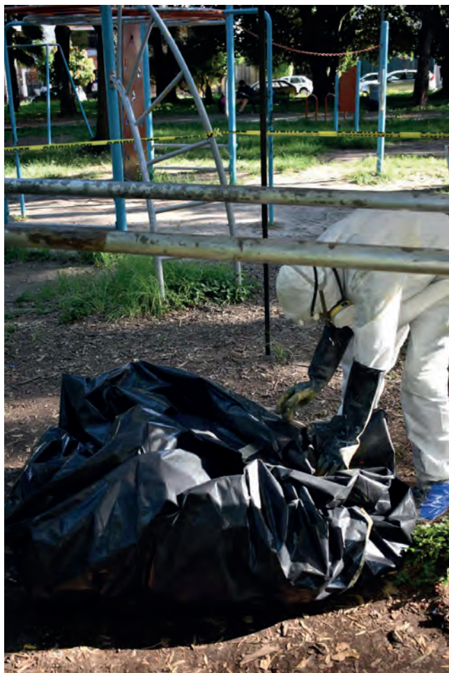
Figura 16. Retiro del forro protector.
