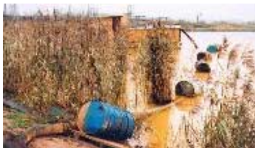
Depósitos obsoletos de pesticidas en Arkhangelsk (Rusia)
