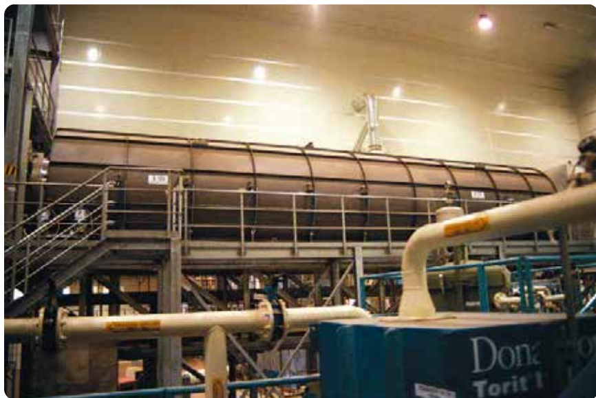
Figura 20. Unidad de Desorción Térmica Indirecta (UDTI) de Spolana en Neratovice. Fuente: Arnika Association
