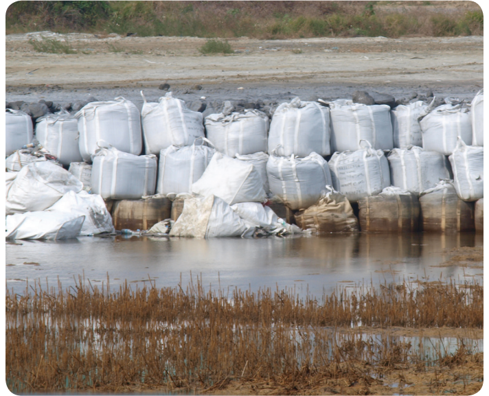
台湾的某个废弃物焚烧飞灰填埋场。
