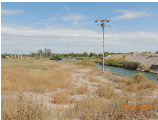
Antiguo sector de piletones para recepción de efluentes industriales, ubicado enfrente de la isla de exIndupa - Imextrade. Observar la proximidad con el curso de agua dulce. (fuente: Taller Ecologista)
