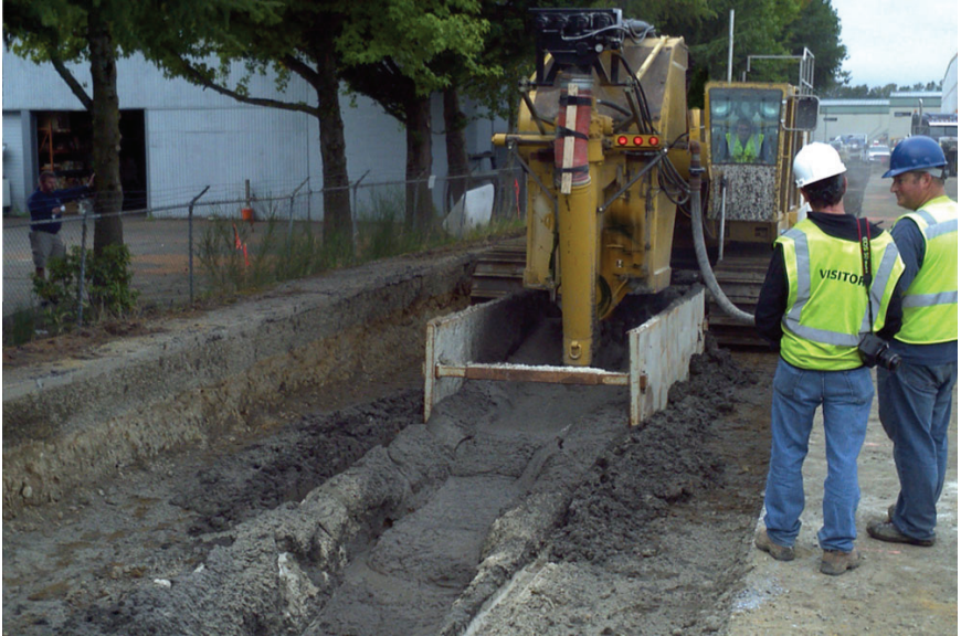
الصورة رقم 10: حفر الخندق ووضع الطين المصدر: www.dewindonepasstrenching.com
