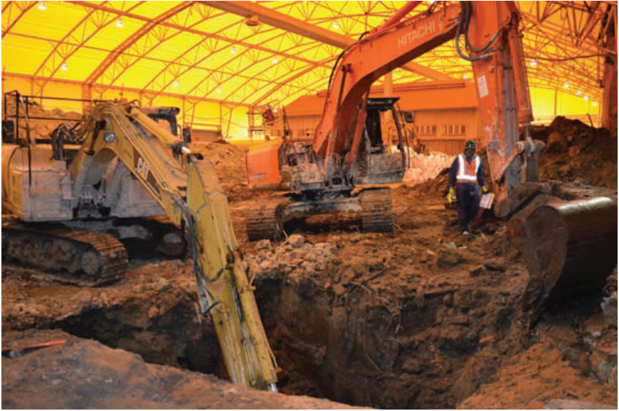
الصورة رقم 8: داخل مستودع التحكم بالروائح أثناء عمليات التجريف. المصدر: الحكومة الفيدرالية الأسترالية.
