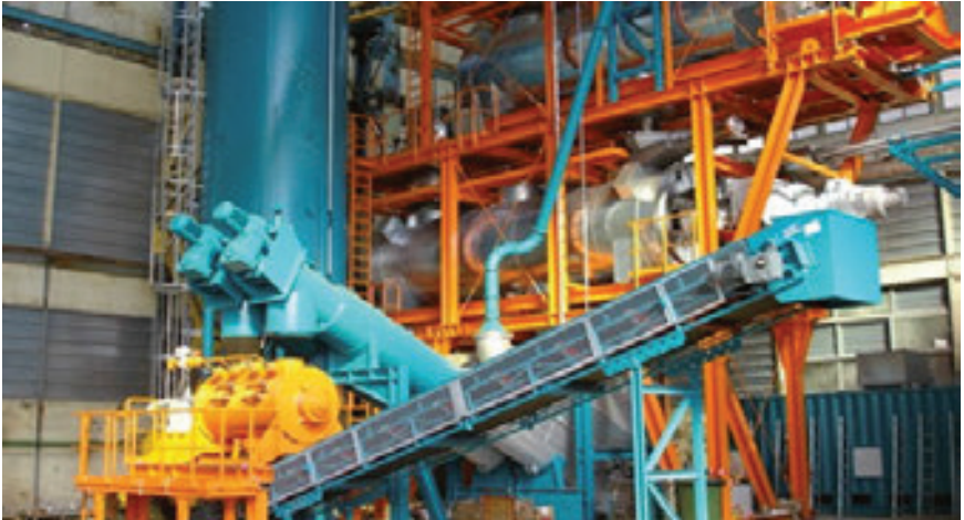
الصورة 15: وحدة التقطير الفراغية بالحرارة غير المباشرة.
