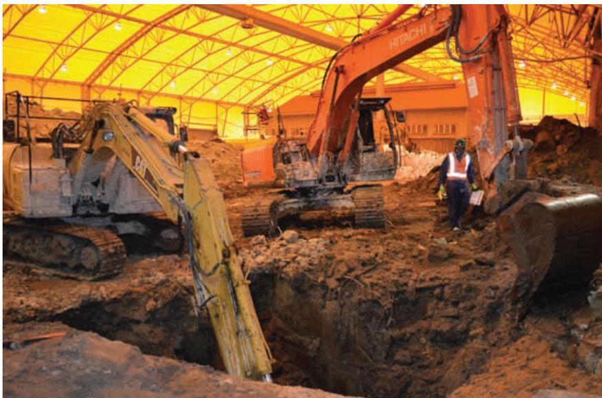
**Imagen 8. Interior del recinto con control de olores durante la excavación.** Fuente: Gobierno Federal de Australia (2013)
