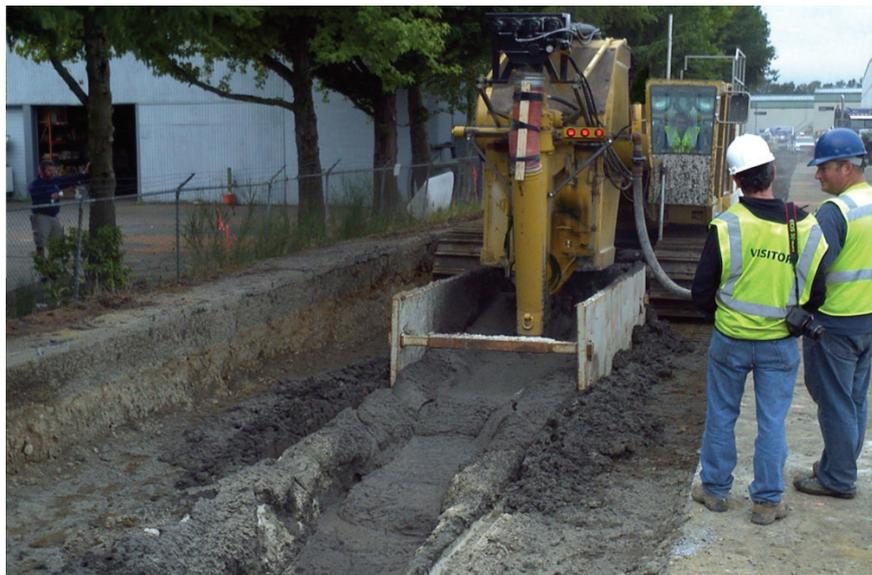
**Imagen 10. Combinación de trinchera e inserción de fraguado.**
