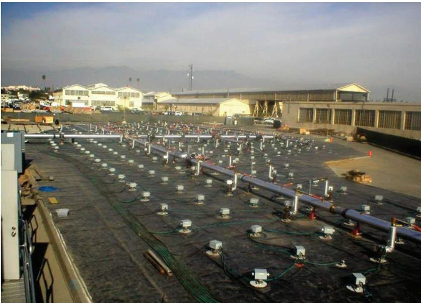
***Imagen 12. Operación de la desorción térmica in situ en gran escala para abordar la contaminación de compuestos orgánicos en Estados Unidos. Fuente: Merly y Hube (2014)***
