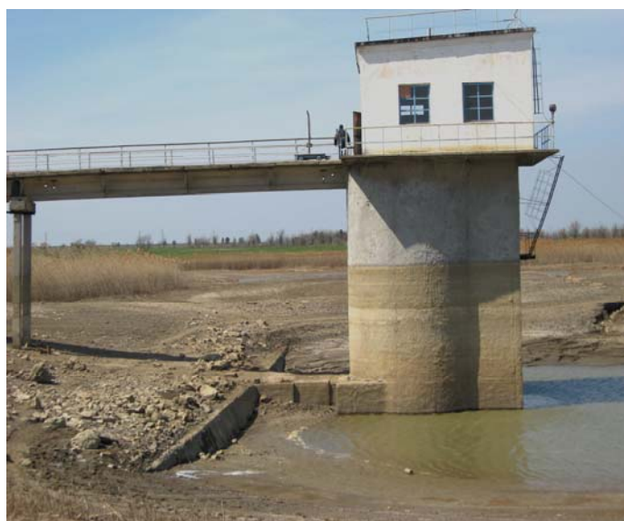
Рис 1. Водозаборная башня Феодосийского водохранилища, апрель 2009 г.
