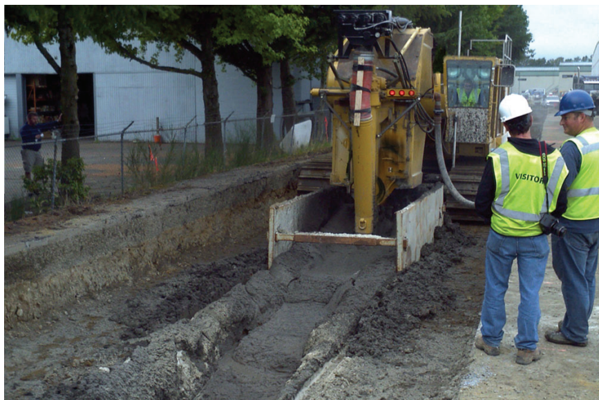
Рис 10. Комбинированная прокладка траншеи с заливкой раствора. Источник: www.dewindonepasstrenching.com
