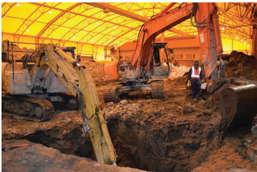
Рис 8. Вид внутри защитного сооружения в ходе выемки грунта.
