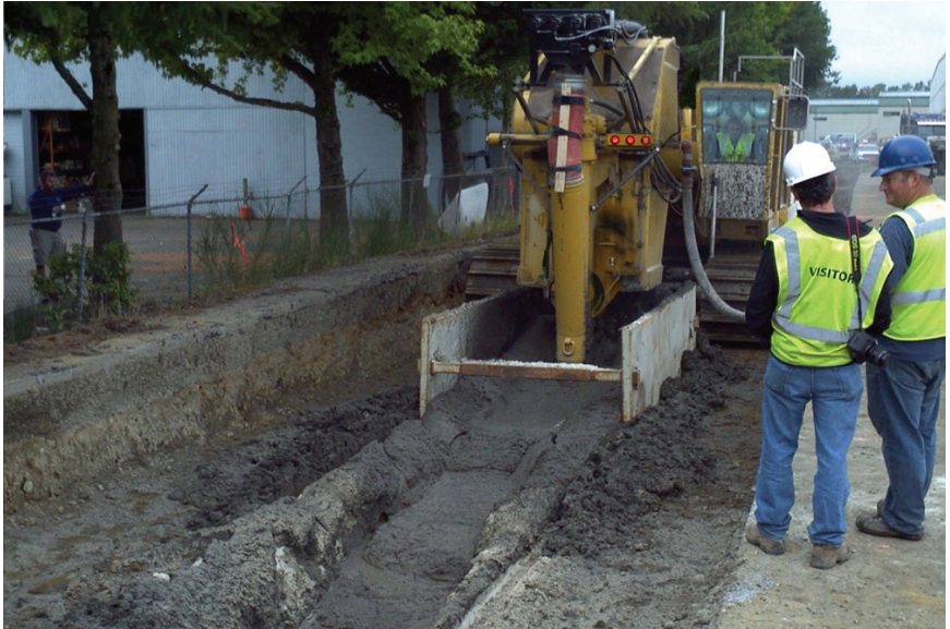
Figure 10. Insertion combinée de tranchée et de boue. Source: www.dewindonepasstrenching.com
