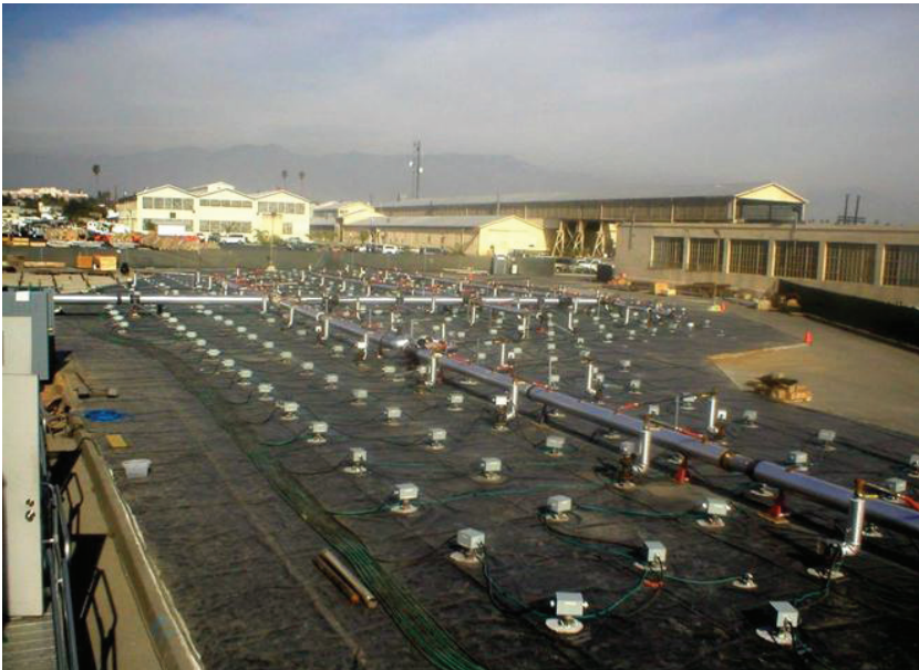
Figure 12. L'Application à grande échelle de la désorption thermique in situ sur la contamination par les composés organiques aux Etats-unis. Source: Merly and Hube (2014)
