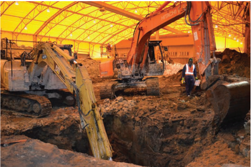
Figure 8. L'intérieur de l'enceinte de contrôle des odeurs lors de l'excavation. Source: Gouvernement Fédéral Australien (2013)
